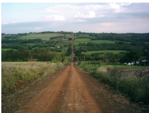
Figura 1 – Estrada de acesso à Linha Paca Norte, Campina das Missões/RS
