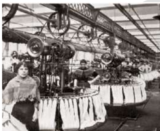
Figura 2 - Trabalhadoras manejam máquinas em uma fábrica na Inglaterra
