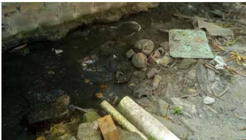
Figura 4 – Esgoto a céu aberto nos fundos da casa de um morador da comunidade
