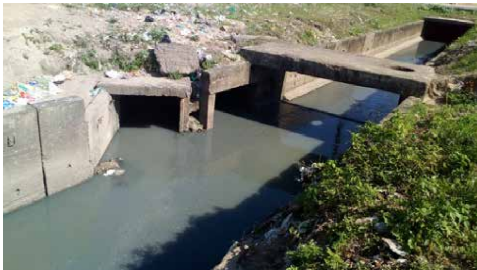
Figura 5 – Valeta de canalização de água pluvial
