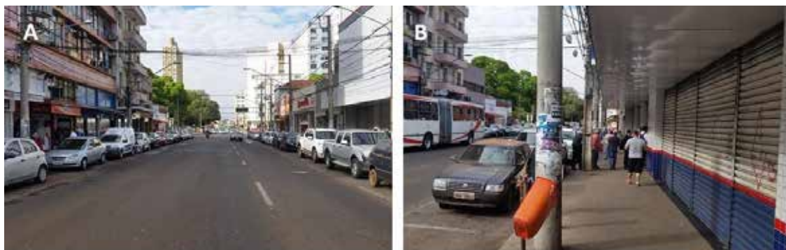
Figura 1 – Aspectos da Rua 14 de Julho antes das obras de requalificação
