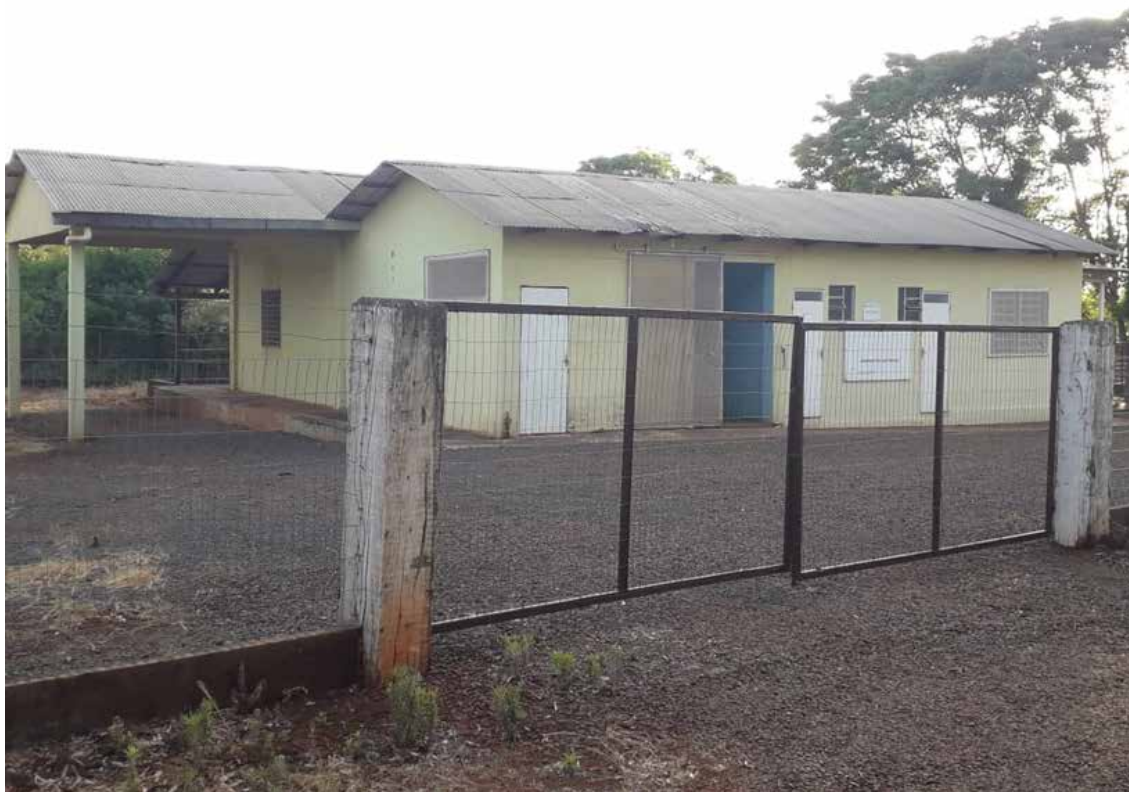
Figura 3 – Prédio da Cooperativa Gama
