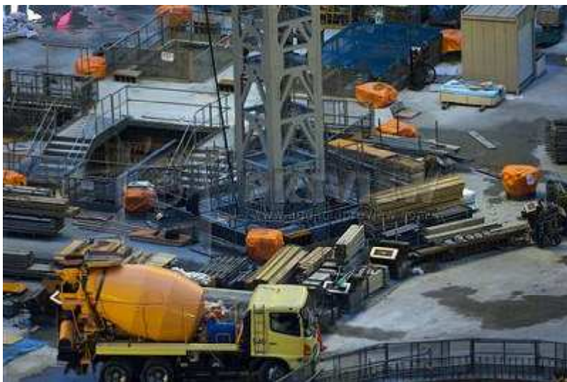
Figura 3: Canteiro de Obras
