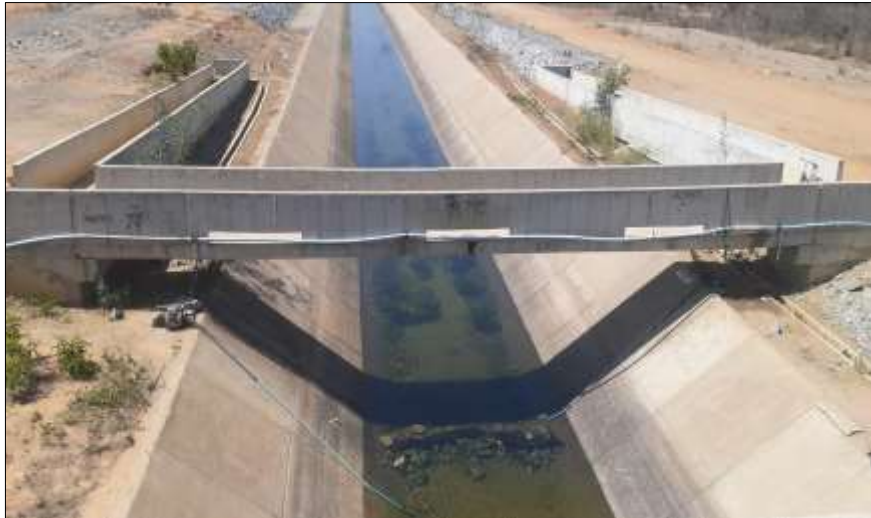
Figura 9 – Bomba instalada para captação de água do Eixo Leste do PISF no Assentamento Serra Negra, Floresta/PE (2023)
