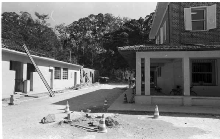
Figura 4 – Casarão e anexo em obras para instalação do parque
